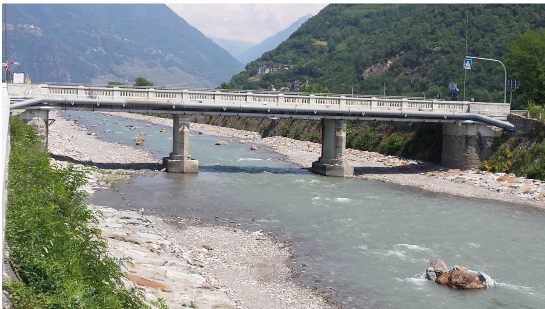
Fig. 1 – Il ponte di Stazzona visto da valle
