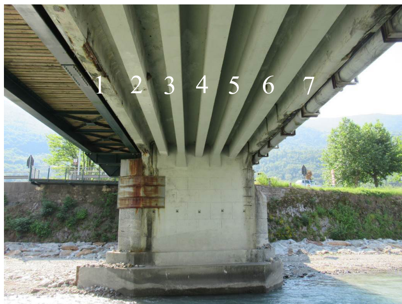
Fig. 2 – pila sinistra con intradosso di impalcato e numerazione delle travi
