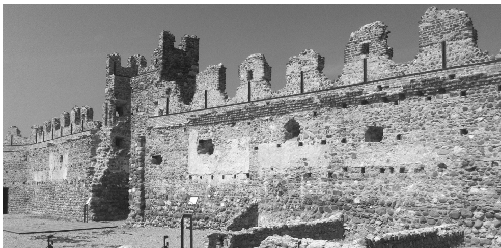
Fig. 3 – Il sistema di raccolta e smaltimento acque visto dall’interno
