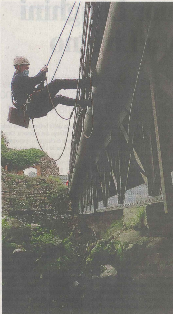
I rilievi dell'impresa tiranese sul Ponte Lungo di Valeggio sul Mincio
