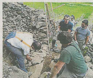
Al lavoro sul versante montuoso
