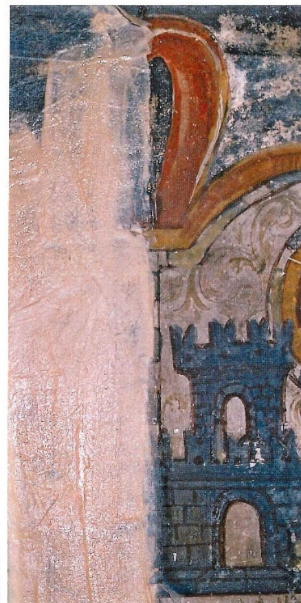
Pulitura mediante l'applicazione di impacco con soluzione acquosa di sali inorganici. (Foto Giorgio Baruta)
