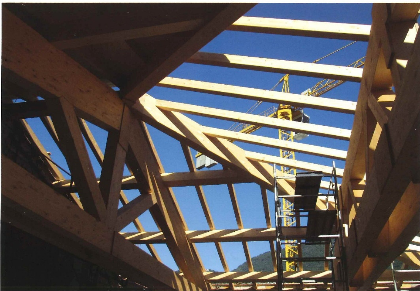
Montaggio dell'orditura lignea, principale e secondaria, della copertura
