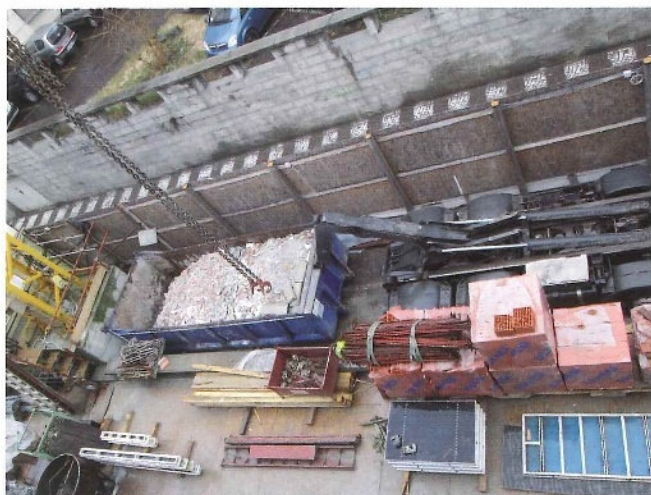
Area esterna di stoccaggio dei materiali
