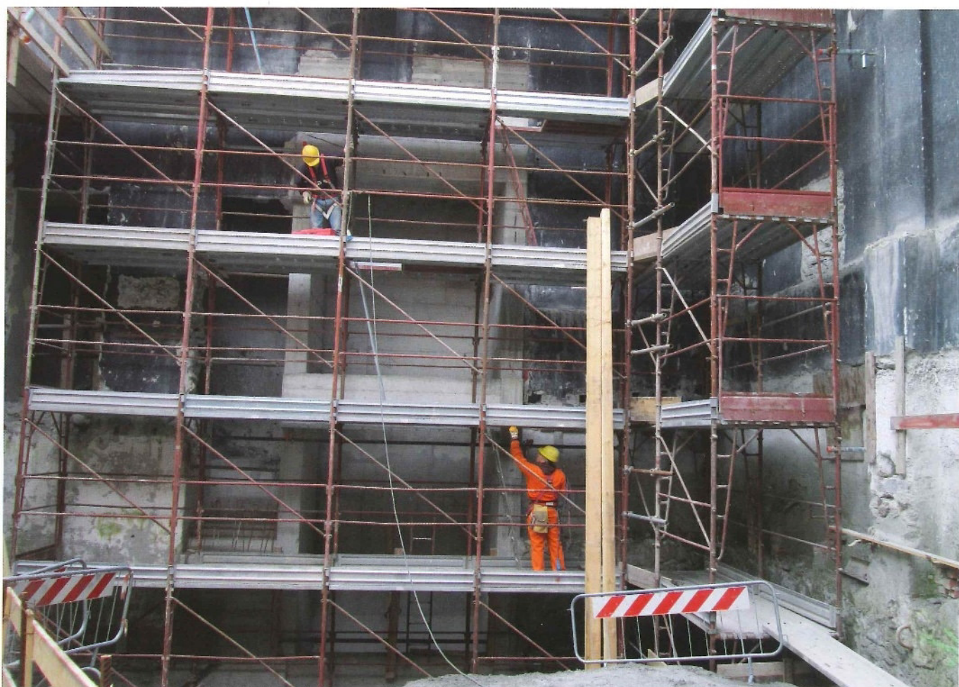
Montaggio ponteggi su torre scenica prima della ristrutturazione
