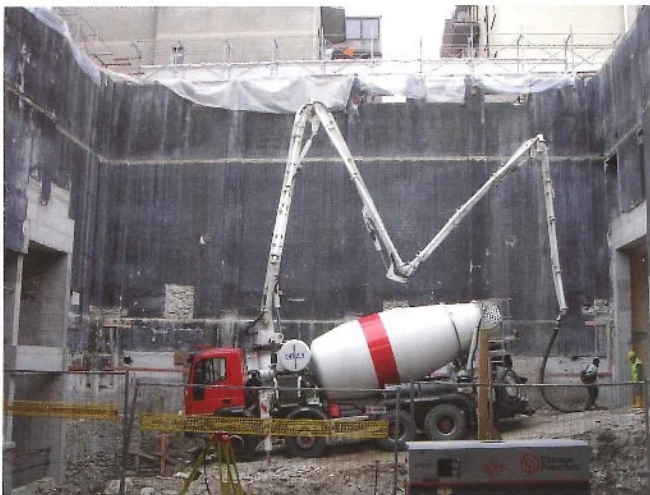
Autobetoniera con pompa, per getti di calcestruzzo nel sedime del futuro palco
