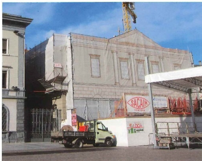
La facciata del teatro durante i lavori
