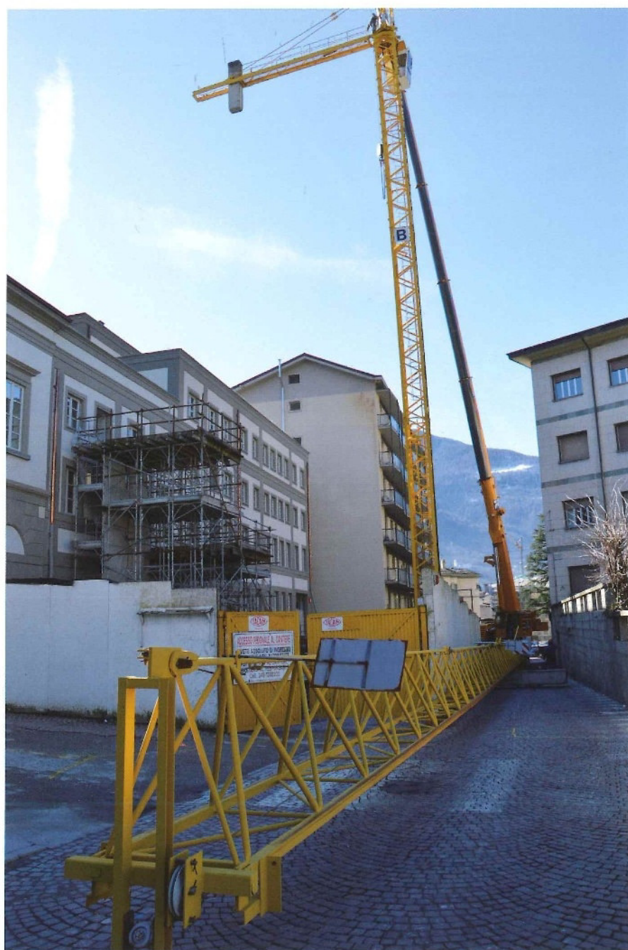
Smontaggio della gru a torre, con l'ausilio di autogru gommata telescopica. Per motivi di sicurezza e di logistica è stato chiuso l'accesso a via Alessi
