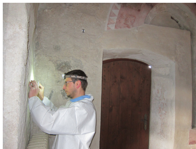
Figura 17 - Il monitoraggio strutturale
