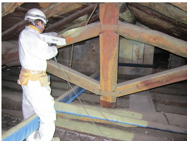
Figura 11 - Esecuzione prova con Resistograph
