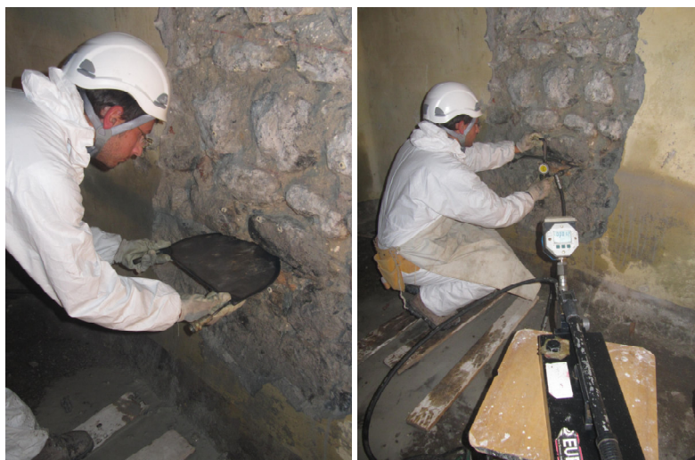
Figura 5 - Fasi di esecuzione della prova con un martinetto piatto
