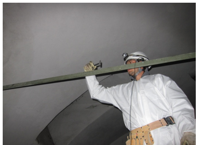
Figura 10 - Rilievi dinamici per la misura dello stato di sollecitazione delle catene
