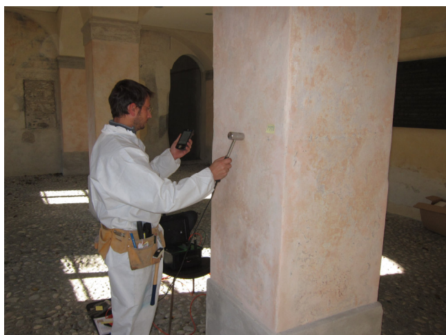
Figura 7 - Esecuzione di misure della velocità di propagazione degli impulsi sonici
