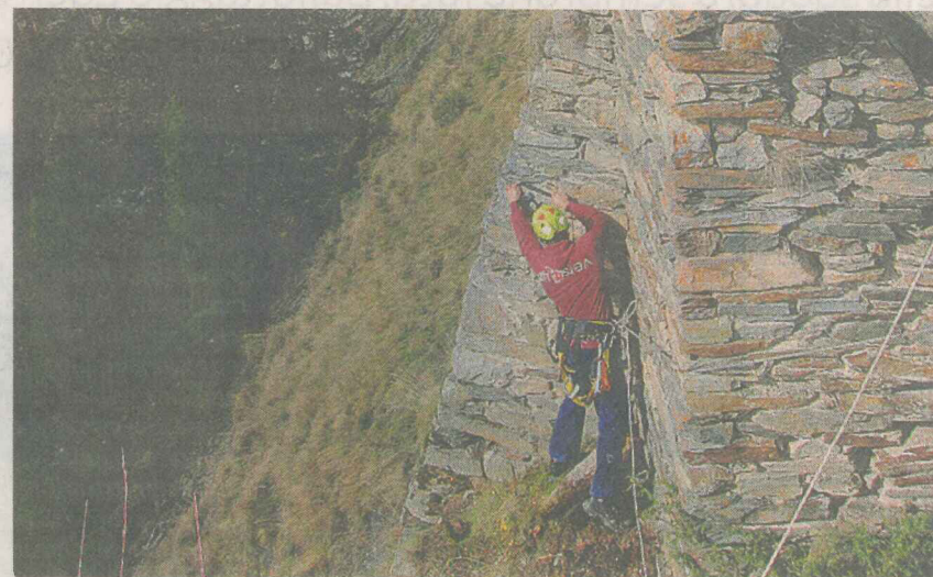
I controlli che sono stati fatti dai tecnici sul muro sotto la chiesa
