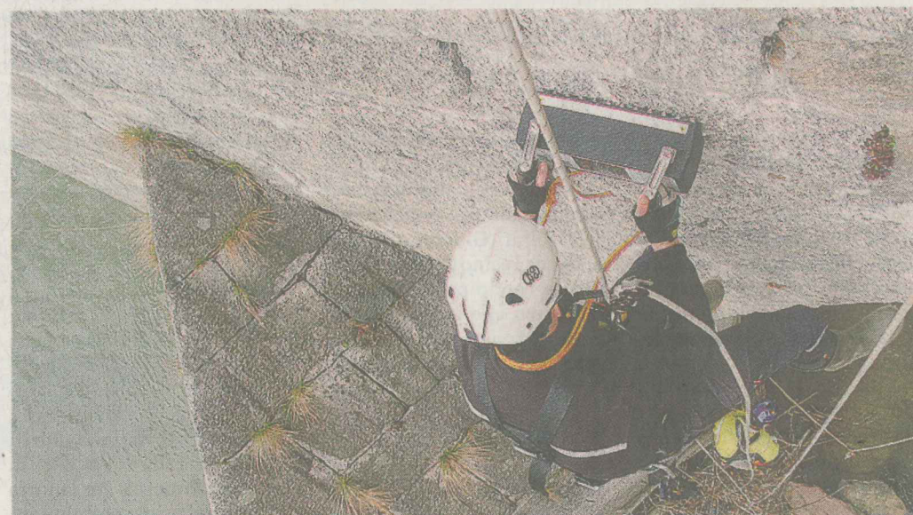
Il momento più spettacolare è stato quando i tecnici si sono dovuti calare sui fianchi del ponte per i rilievi
