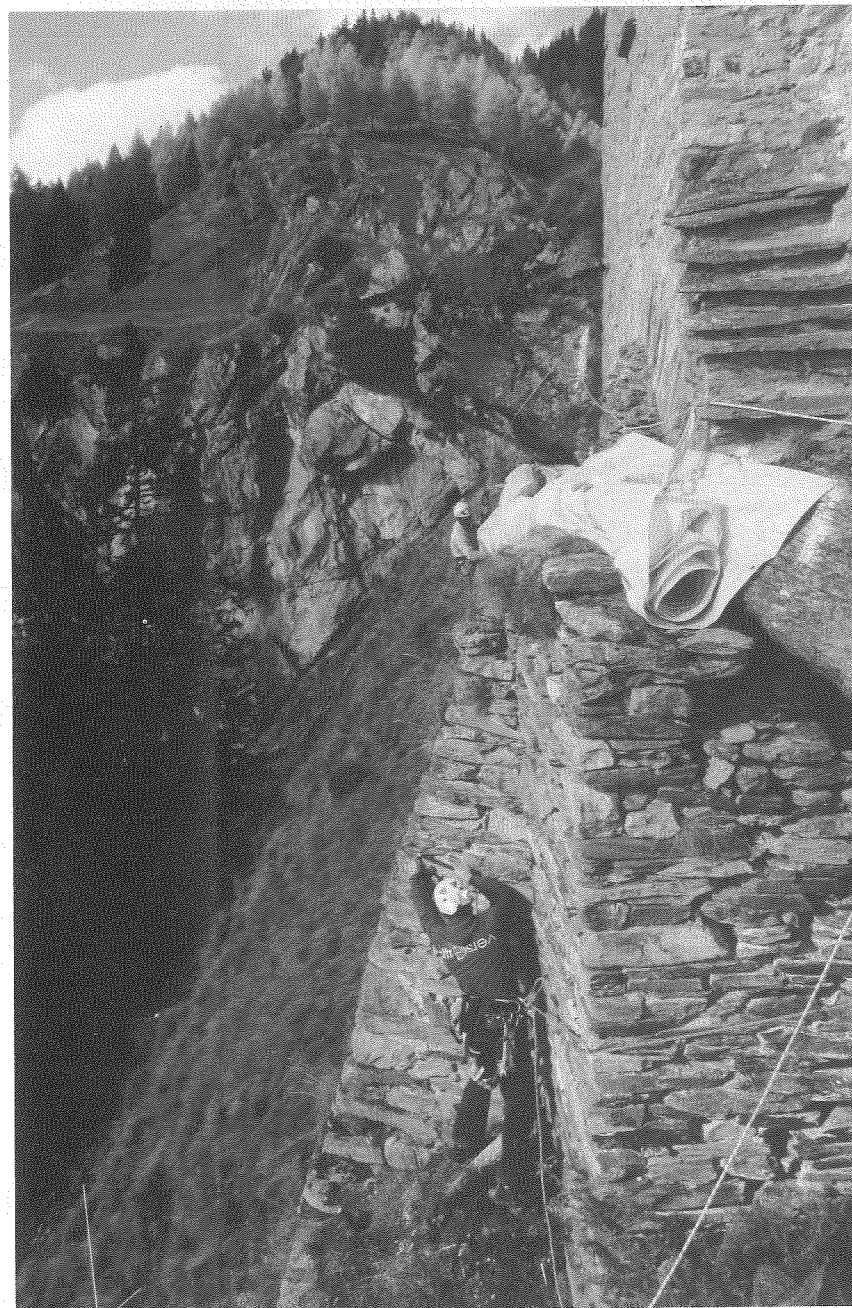
Posizionamento del telo verde per proteggere il contrafforte
