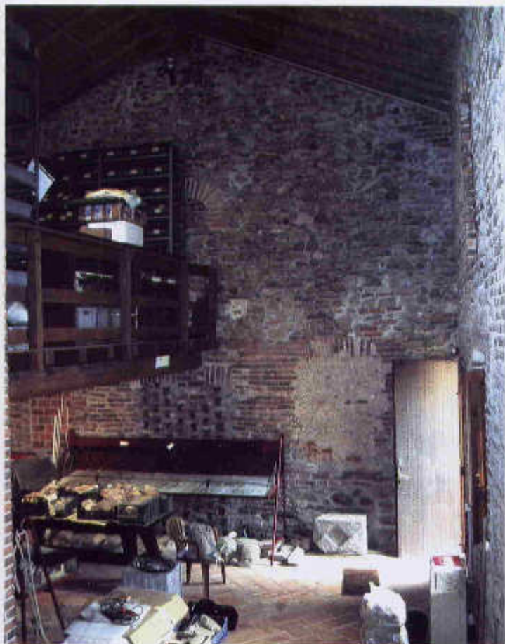
FIGURA 4 • Castelseprio, parco archeologico, Cascina Monastero di San Giovanni. Stato di fatto della cascina: l'ambiente della cascina era costituito da un vano a doppia altezza, da un pavimento in piastrelle in cotto appoggiate su un massetto a diretto contatto con la terra e da un soppalco in legno che si innestava al centro della facciata della chiesa.
