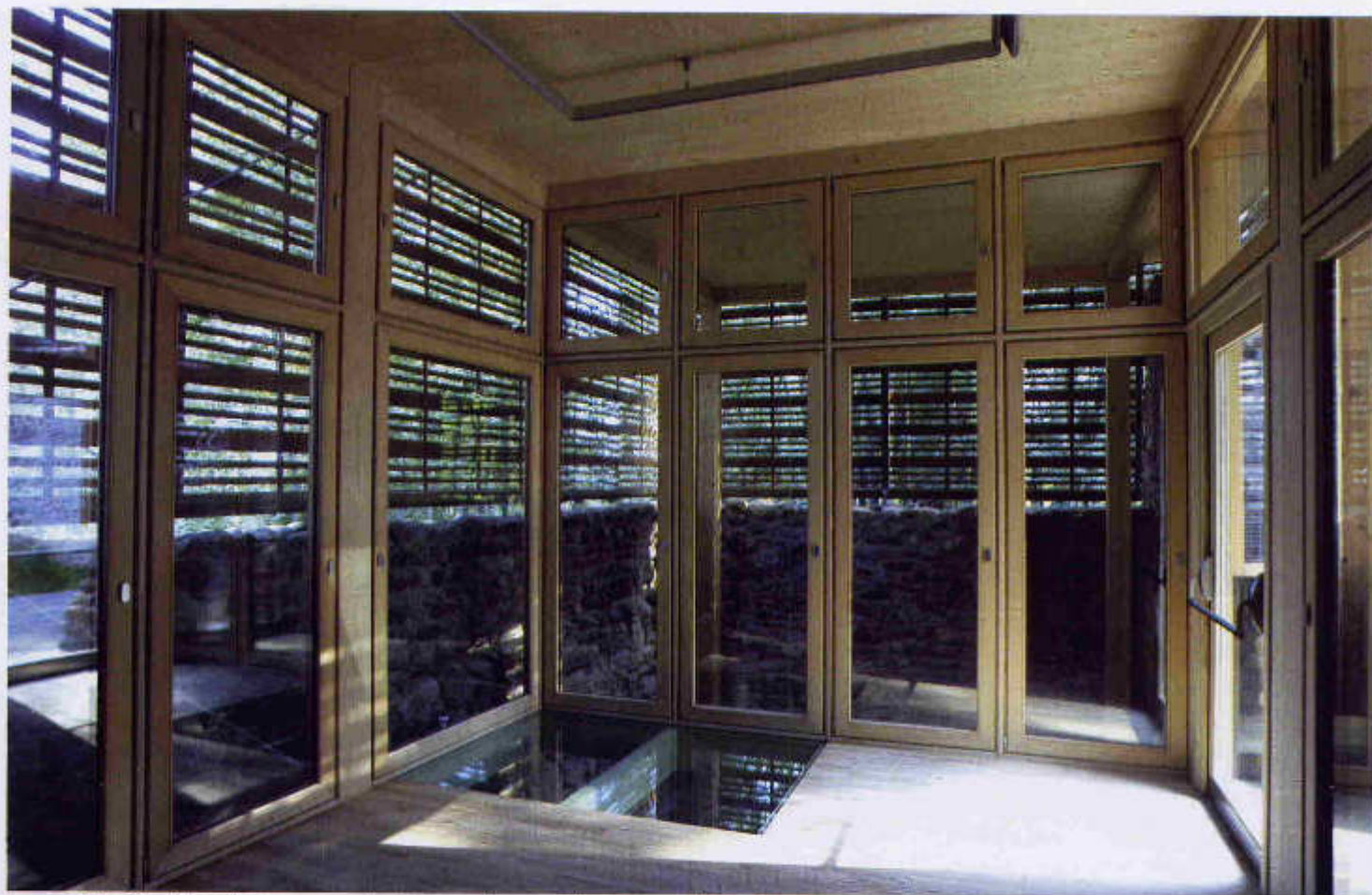
FIGURA 20 • Castelseprio, parco archeologico, Cascina Monastero di San Giovanni. Il nuovo volume caratterizzato da trasparenza e reversibilità: la struttura a telaio è in legno lamellare di abete. Tiranti Ø 12 in acciaio zincato ad alta resistenza, mantenuti a vista, sono stati utilizzati per i controventi e i rinforzi dei muri contro terra.
