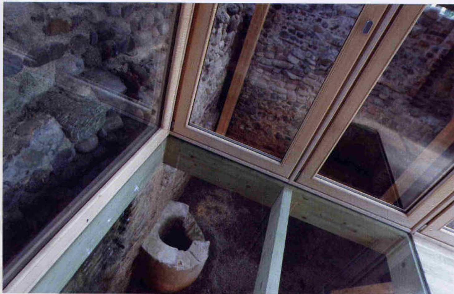
FIGURA 21 • Castelseprio, parco archeologico, Cascina Monastero di San Giovanni. Particolare della pavimentazione. In seguito al rinvenimento del locale seminterrato si rese indispensabile la modifica del nuovo volume con un ridimensionamento dell'area pavimentata e l'inserimento di alcune lastre in vetro strutturale calpestabile.
