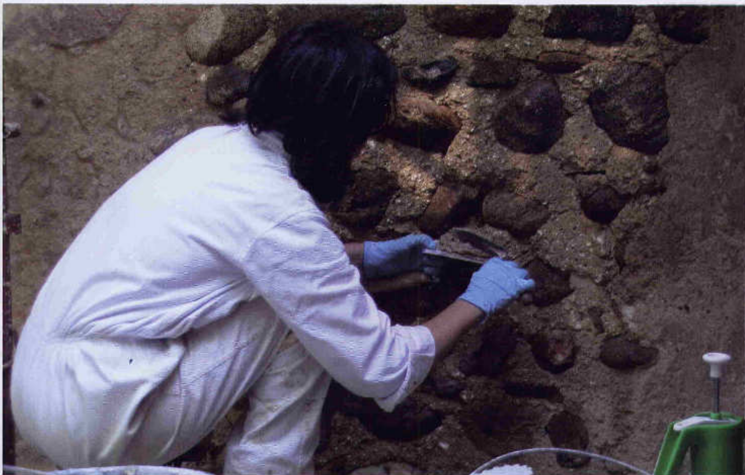
FIGURA 6 • Castelseprio, parco archeologico, Cascina Monastero di San Giovanni. Consolidamento e ristilatura dei giunti di malta. Negli spazi vuoti tra i conci e i laterizi del paramento è stata applicata la malta di ristilatura, in leggero sottolivello, seguita da un lavaggio superficiale in fase di media presa, per metterne in evidenza le cariche.
