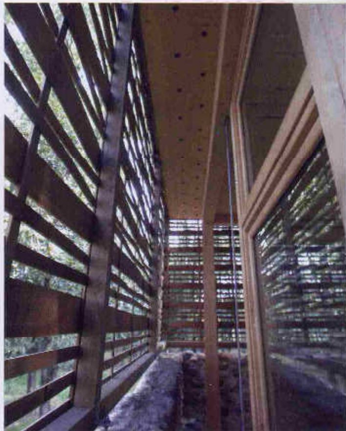
FIGURA 24 • Castelseprio, parco archeologico, Cascina Monastero di San Giovanni. Particolare dell'innesto tra struttura nuova e muratura antica: la nuova struttura, completamente indipendente dai muri esistenti, è impostata su puntoni in legno opportunamente controventati con tiranti metallici e in parte appesa alla copertura.
