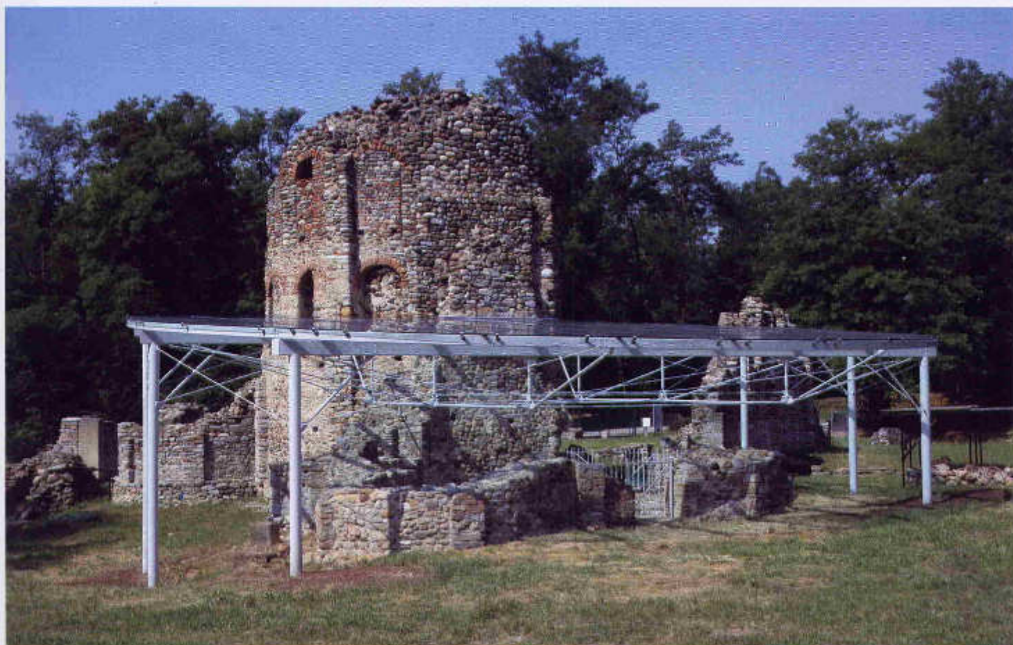
FIGURA 31 • Castelseprio, parco archeologico, Cascina Monastero di San Giovanni. La nuova copertura del battistero: l'ampia superficie (165 m 2 ) è dettata dalla necessità di impostare i pilastri di sostegno ben al di fuori del perimetro del battistero in modo da non interferire con esso e con le sepolture esterne.
