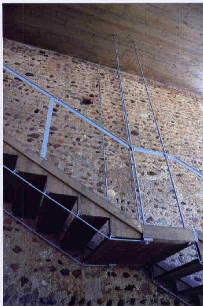
FIGURA 17 • Castelseprio, parco archeologico, Cascina Monastero di San Giovanni, particolare della scala esterna sospesa alla copertura. La scala, con pedate in legno, è sostenuta da una doppia struttura leggera in acciaio zincato sospesa per mezzo di tiranti.
