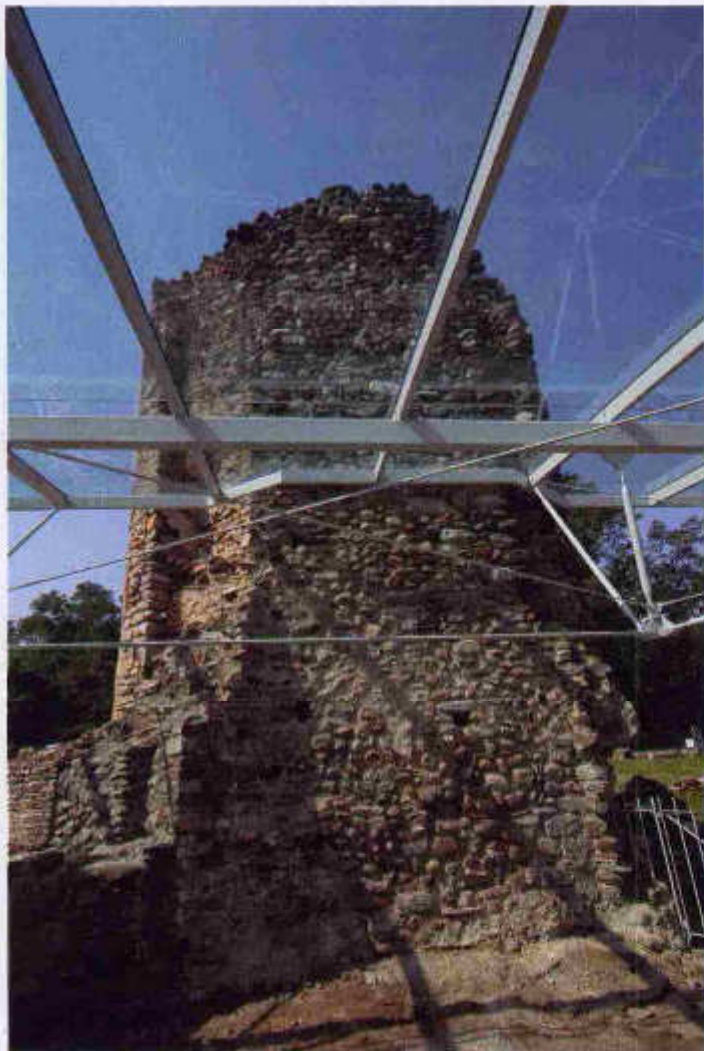
FIGURA 32 • Castelseprio, parco archeologico, Cascina Monastero di San Giovanni. La copertura del battistero verso l'abside di San Giovanni: la struttura portante è in acciaio e la copertura in lastre di vetro stratificato.
