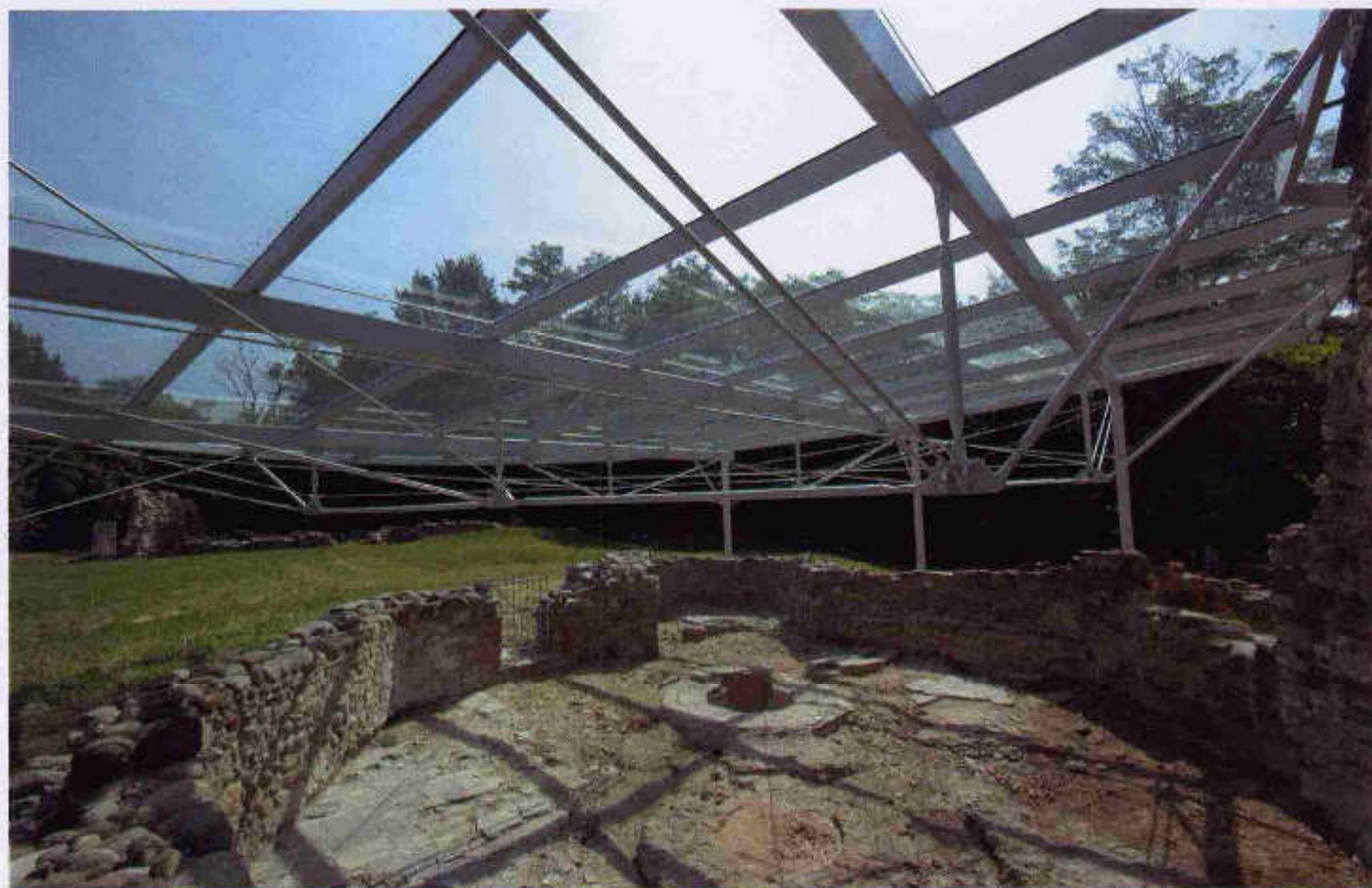
FIGURA 33 • Castelseprio, parco archeologico, Cascina Monastero di San Giovanni. Copertura del battistero presso l'abside di San Giovanni: i profili necessari al fissaggio longitudinale delle lastre sono stati progettati in ferro zincato nervato, la lattoneria in acciaio inox satinato 10/10 mm.
