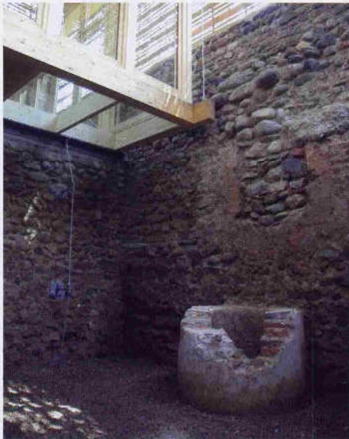
FIGURA 22 • Castelseprio, parco archeologico, Cascina Monastero di San Giovanni. Particolare del locale interrato: gli scavi archeologici hanno portato alla luce, in una parte del sedime dell'ala conventuale, un ambiente interrato provvisto di aperture tamponate in antico e di un pozzo che s'impasta su un pavimento in battuto di malta.
