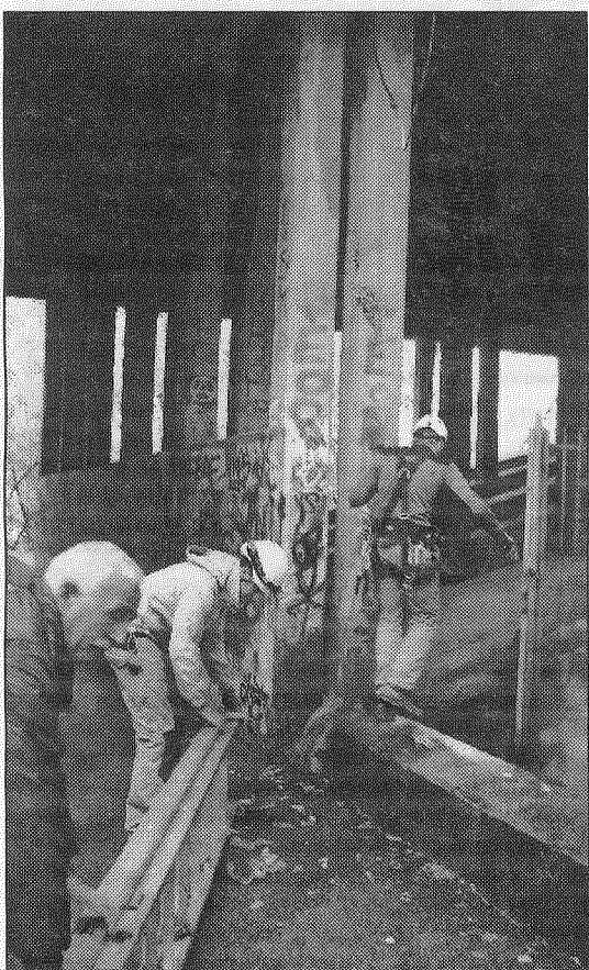
TECNICI AL LAVORO sul Ponte Nuovo o della Vittoria
