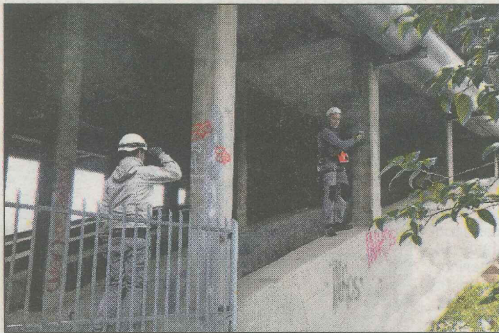
TECNICI AL LAVORO sulle arcate del Ponte Nuovo
