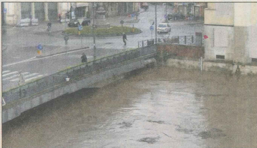
TORNA LA PAURA Bacchiglione a Ponte degli Angeli
