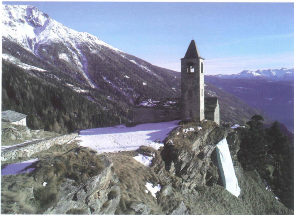
La posa del telo di protezione
