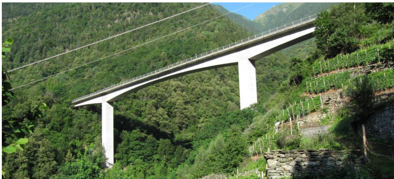
Fig. 1 - il ponte oggetto di analisi
