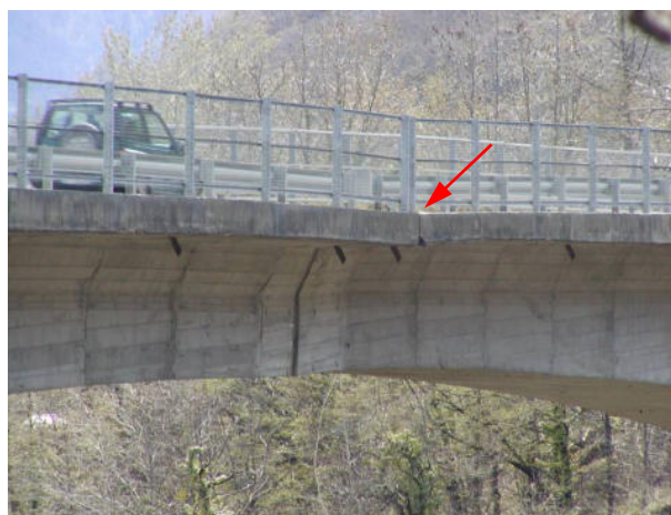
Fig. 3 - particolare del giunto in mezzeria
