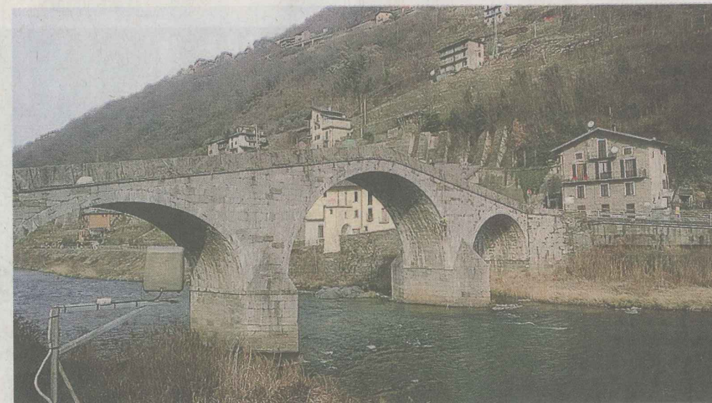
Il ponte di Ganda è un sorvegliato speciale FOTO SANDONINI
