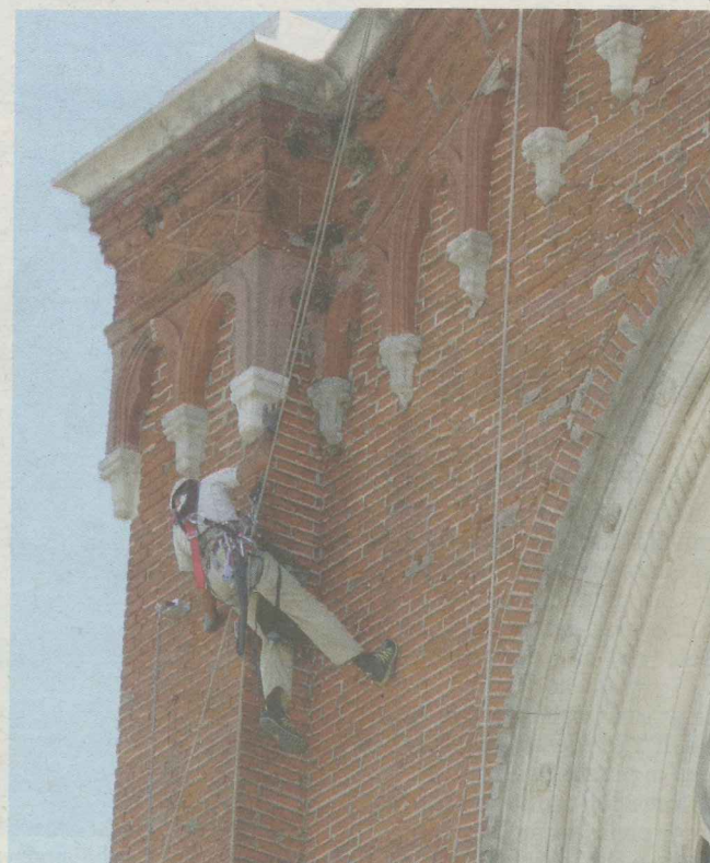
I tecnici sulla facciata del Tempio Ossario. FOTO CECCON
