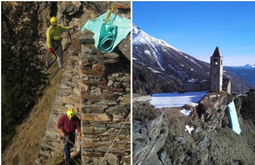
Figg. 11, 12 - Intervento di protezione del contrafforte di valle.
