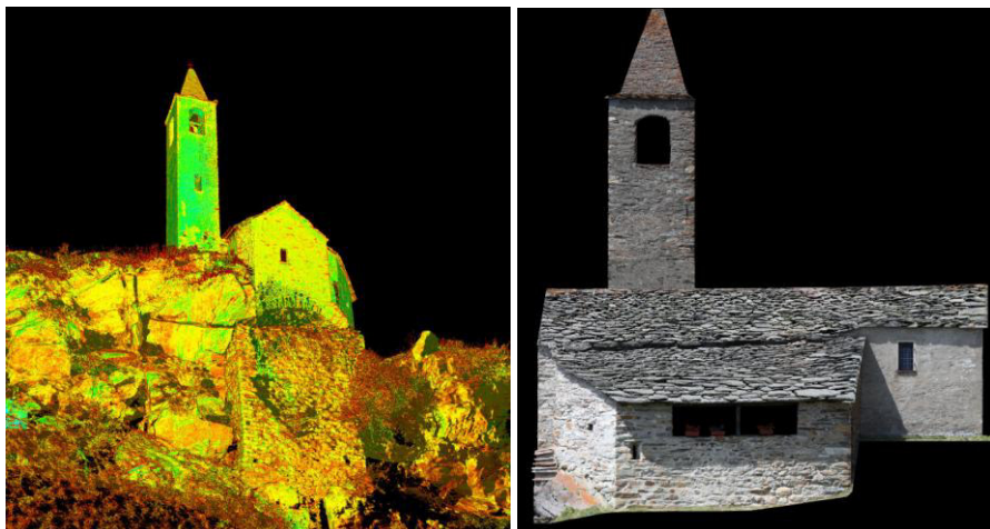
Figg. 5, 6 - Nuvola di punti del rilievo laser-scanner e prospetto.
