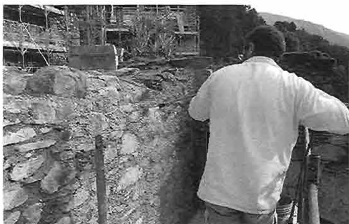
Idrolavaggio a pressione controllata di tutte le superfici anche per l'eliminazione del prodotto biocida.
