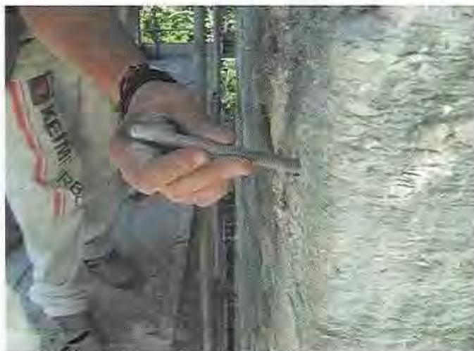
Su alcuni conci fratturati si è provveduto all'inserimento di barrette filettate in inox con resine epossidiche e/o acriliche per permetterne la messa in sicurezza, sono state successivamente eseguite delle microstuccature con malta fine o resine epossidiche e/o acriliche per sigillare le fratture scongiurando l'infiltrazione di acqua all'interno.
