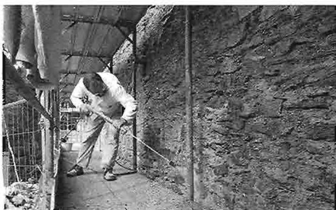
Idrolavaggio puntuale e a pressione controllata delle malte che ha permesso di eliminare il materiale fine presente in superficie lasciando apparire maggiormente il materiale grossolano simile all'originale.
