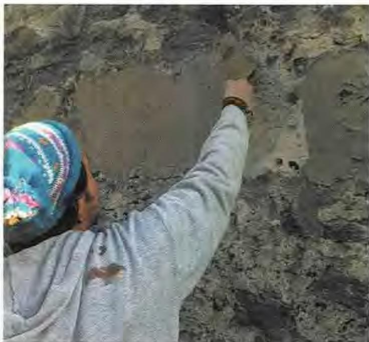
Stesura dell'impacco in sepiolite con acqua demineralizzata e piccola carica di carbonato di ammonio per la pulitura dei lacerti di intonaco.
