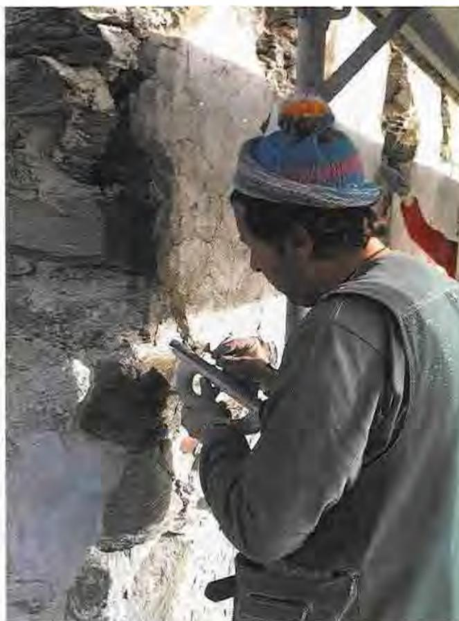
Sulle preesistenze di intonaco si è provveduto alla stuccatura dei bordi, all'iniezione di maltina fluida in calce per la riadesione al supporto murario, intervento con impacco per l'estrazione dei sali, al consolidamento delle superfici con silicato di etile ed alla protezione con prodotto silossanico.
